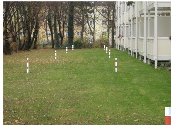
Feuerwehruzufahrt mit Randbegrenzung
