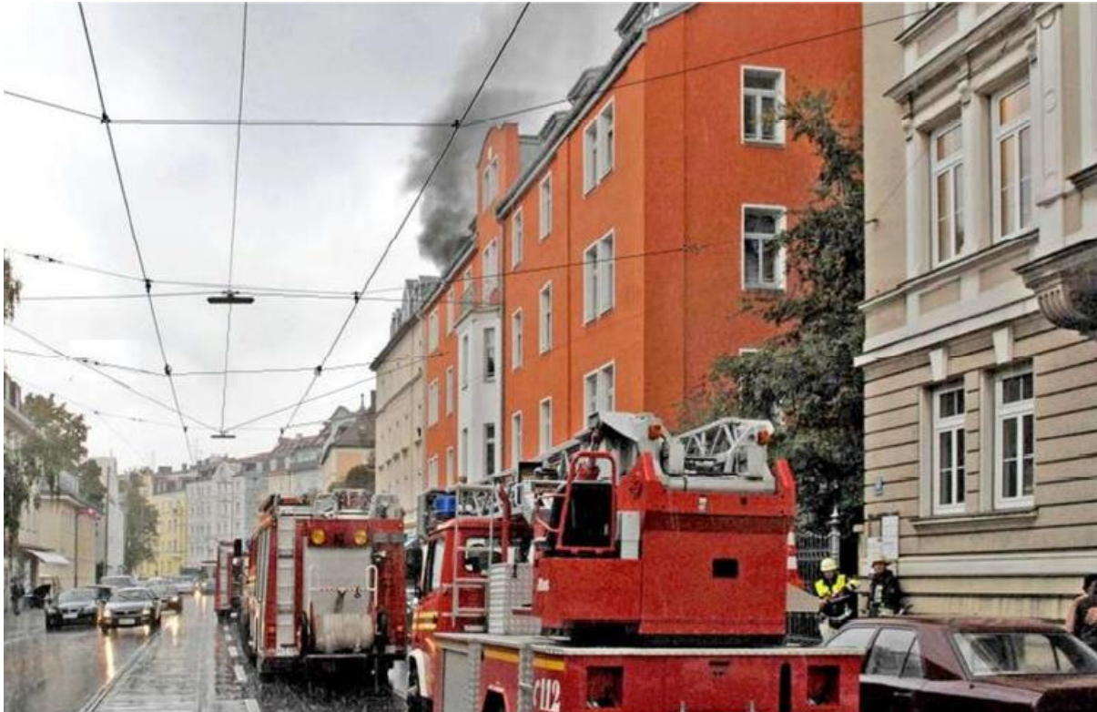
Oberleitungen - Die Anleiterung wird durch den Fahrdrabt erheblich behindert und ist durch die seitlichen Abspannungen nicht möglich.
