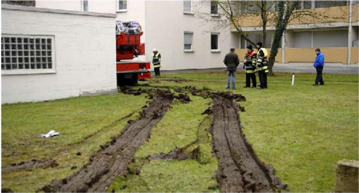
Feuerwehrezufahrt mit nachträglicher Humusbildung
